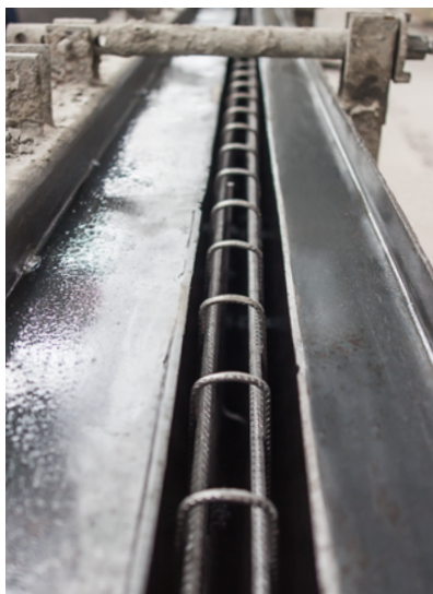
Aguardando a concretagem.
