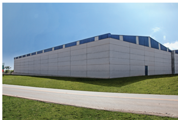
Exemplo de obra.
