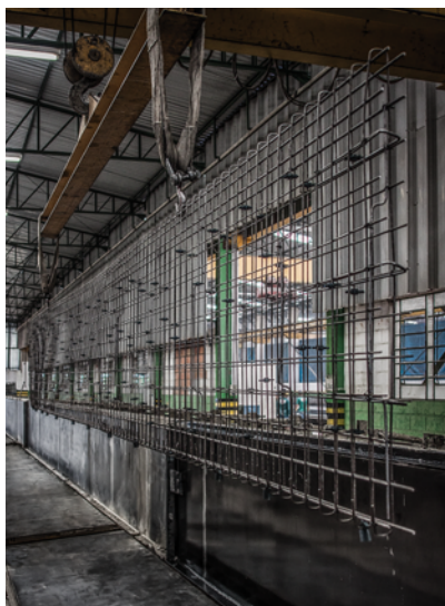
Posicionando na fôrma.
