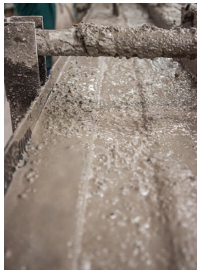
Preenchendo com concreto.
