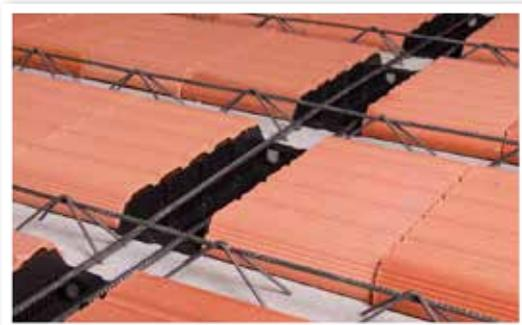
As lajes unidirecionais são aquelas constituídas por vigotas treliçadas disposta em uma única direção, as quais são as responsáveis por suportar as cargas aplicadas. Nelas podem existir as nervuras transversais, sendo utilizadas basicamente como travamento das vigotas treliçadas, contribuindo para a redução da fissuração e eventualmente dos deslocamentos da laje.
