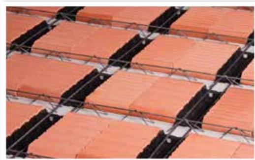
As lajes bidirecionais são constituídas por armaduras principais nas duas direções. Neste caso, em uma direção são posicionadas as vigotas treliçadas e na direção perpendicular são executadas as nervuras transversais. Neste caso as cargas são suportadas pelas vigotas treliçadas e as nervuras estruturais transversais.
